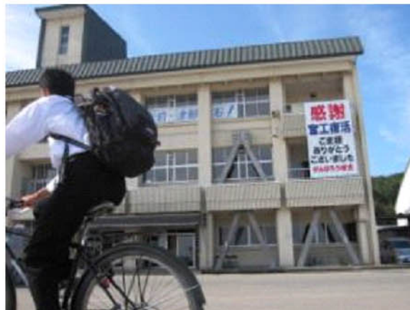
復旧工事が終わり、元の校舎に戻った日（8月29日）の写真
