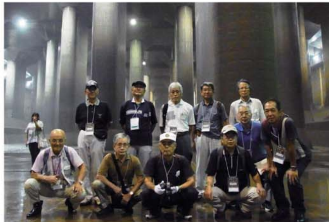
首都圏外郭放水路・調圧水槽内にて
